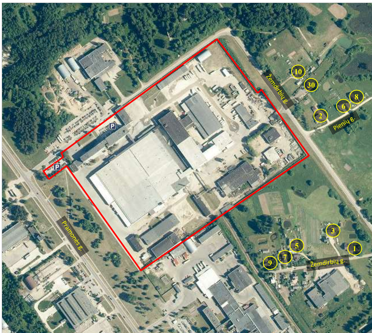
1 pav. PŪV sklypo ribos (raudonai) bei artimiausios gyvenamosios paskirties pastatai (geltonai)
